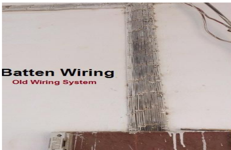
(Fig.5.3. Batten Wiring)
